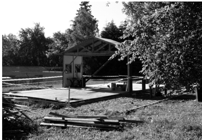
Le chalet en cours de démontage
