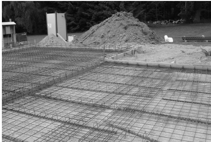
Travaux de coffrage des fondations
